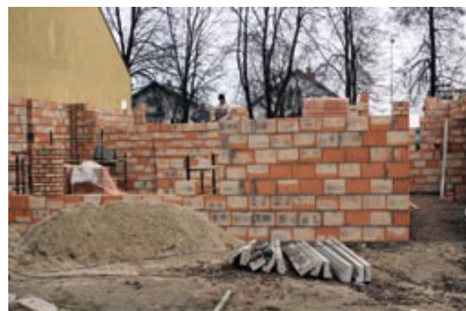
Rozbudowa Ośrodka Kultury w Serocku
